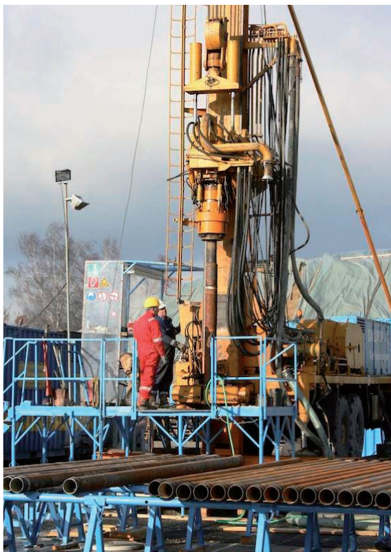
Abb. 26: Bohrung der NAGRA mit dem Bohrturm. Im Vordergrund liegt das Bohrgestänge, welches während der Bohrung Stück für Stück verlängert wird, bis die Bohrung ihre Gesamttiefe erreicht hat und das Gestänge hochgezogen und wieder auseinander geschraubt wird. Die NAGRA (Nationale Genossenschaft für die Lagerung radioaktiver Abfälle) ist für die sichere Endlagerung der in der Schweiz anfallenden radioaktiven Abfälle und für die damit verbundenen Forschungsarbeiten verantwortlich.
