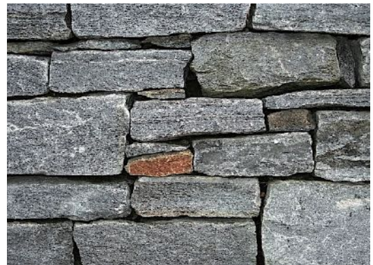
Mauer aus Gneis ohne Zement (Trockenmauer).
