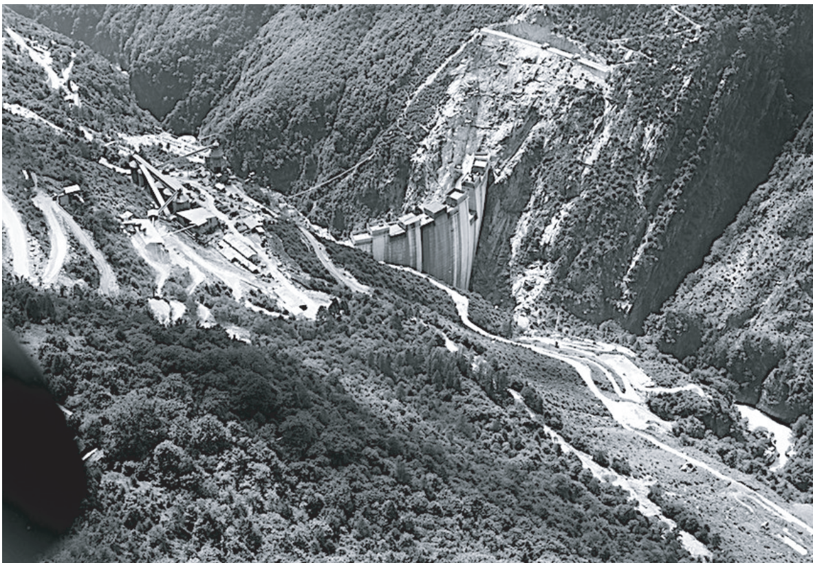
Abb. 6: Bau der Staumauer, links im Bild die Betonproduktionsanlage. Der Beton wurde in Kübeln mittels einer Seilbahn über die Baustelle transportiert (Foto Archiv ETH).
