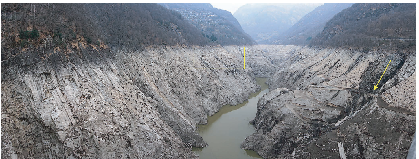
Abb. 3: Lago die Vogorno im entleerten Zustand im Winter 2021/2022. Sowohl die Brücke des alten Fahrweges (Pfeil) wie auch die Terrassierung der Felder (Rahmen) haben annähernd 60 Jahre unter Wasser weitgehend unbeschadet überstanden. Sogar Baumgerüste sind noch zu sehen. Der Stausee wurde seit 1965 nie mehr entleert.
