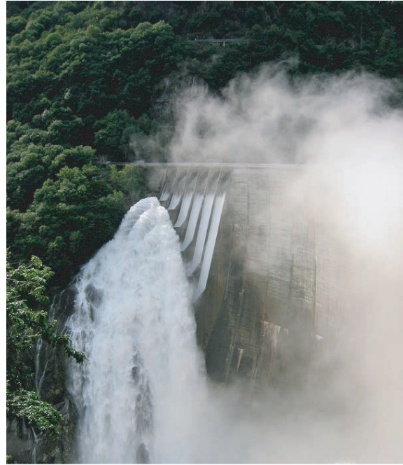
Abb. 5: Geöffnete Hochwasserentlastungen (Foto: https://canyon.carto.net/ ).
